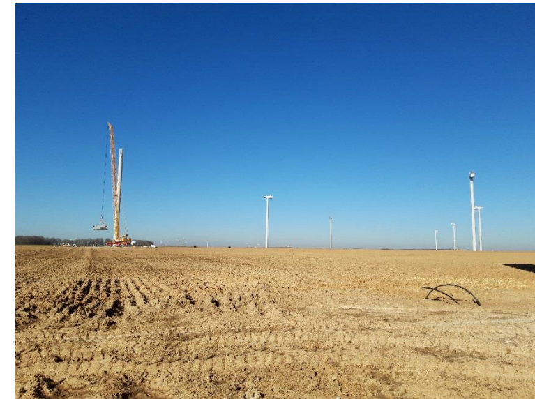
Figure 63 : Un parc de neuf éoliennes Vestas V112 en construction (Source : VOLKSWIND)
