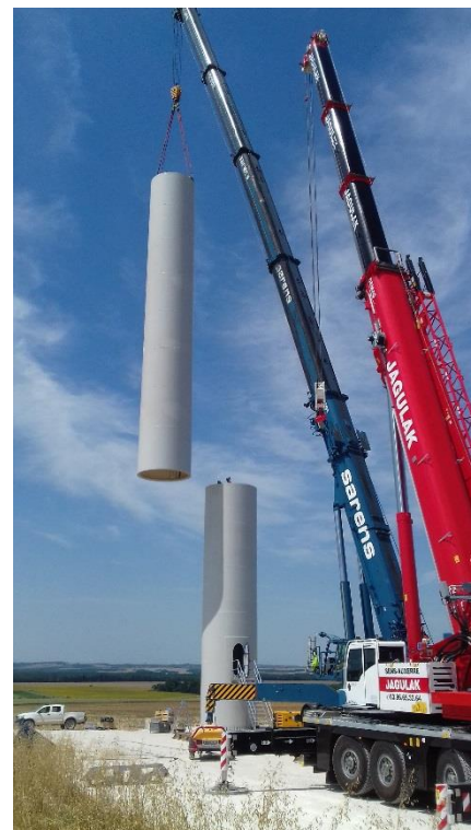
Figure 59 : Montage de la seconde section du mât
