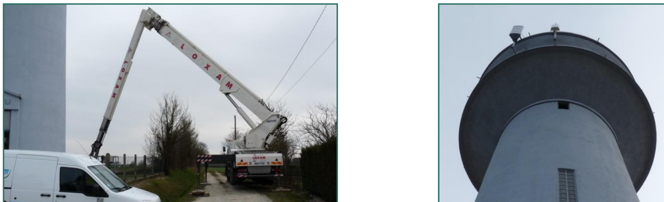
Figure 76 : Installation d'un réémetteur sur un château d'eau
