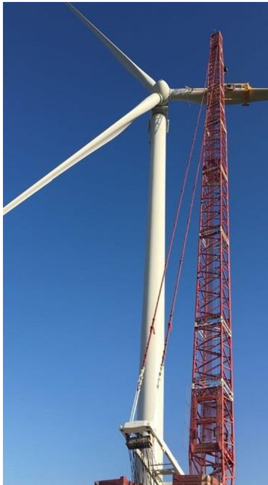
Figure 62 : Montage des pales (Source : VOLKSWIND)
