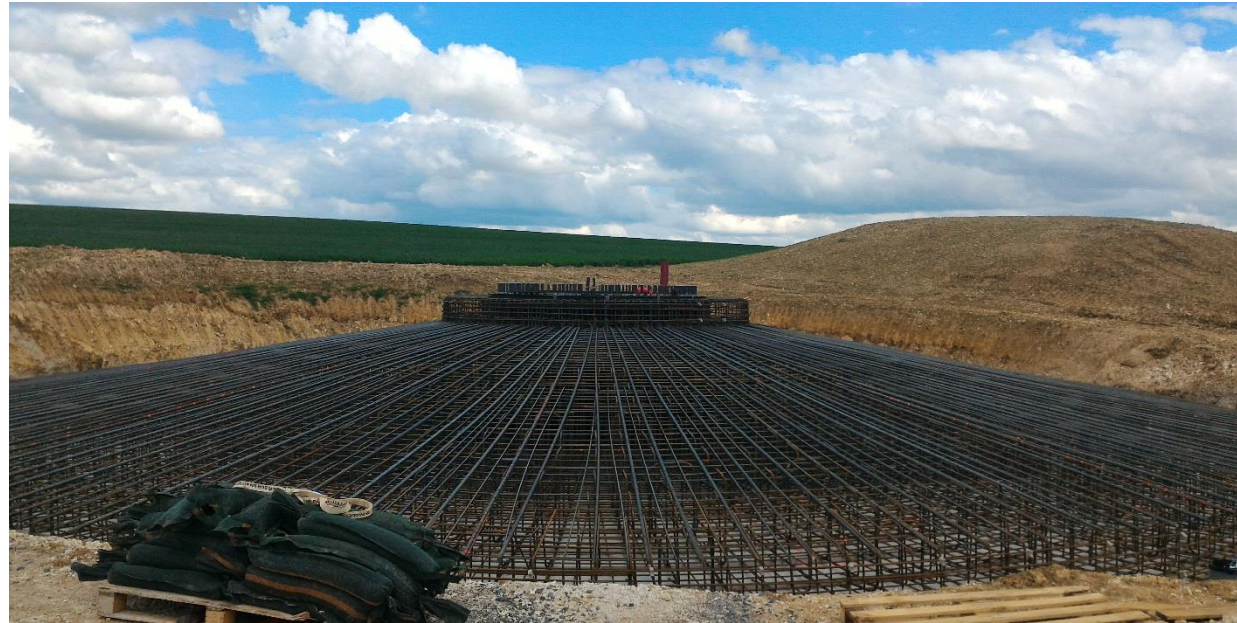
Figure 52 : Ferrailage du massif
