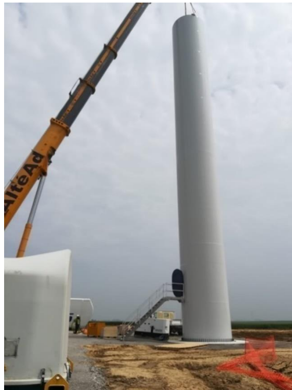
Figure 58 : Montage de la première section du mât
