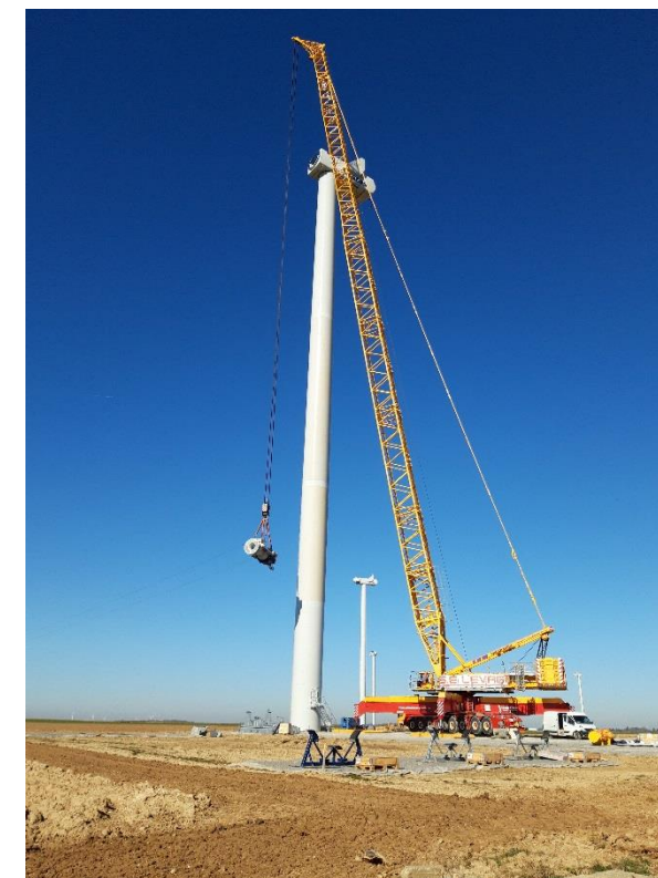
Figure 61 : Montage de la génératrice
