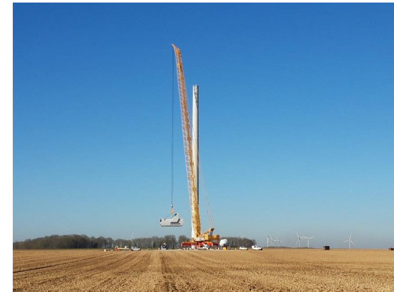
Figure 60 : Montage de la nacelle
