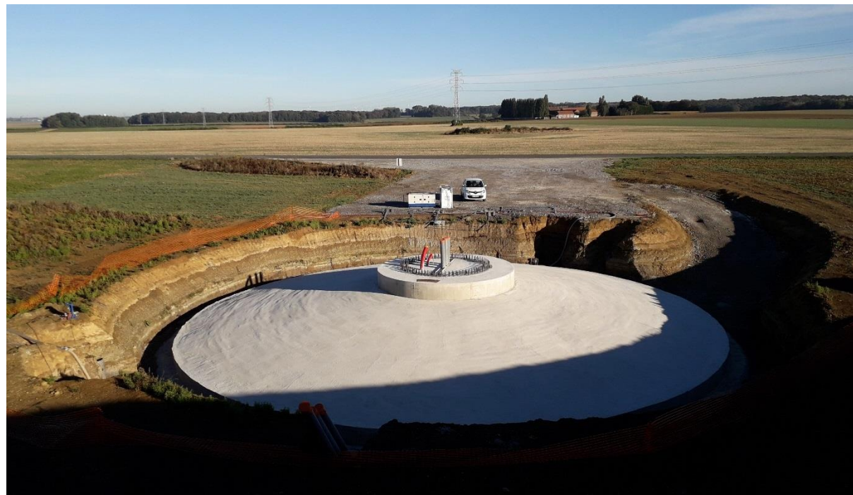
Figure 53 : Fondation après coulage béton
