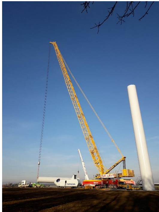
Figure 54 : Grue permettant l'assemblage des différents éléments d'une éolienne
